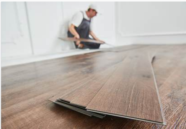
Pavimento con effetto legno
